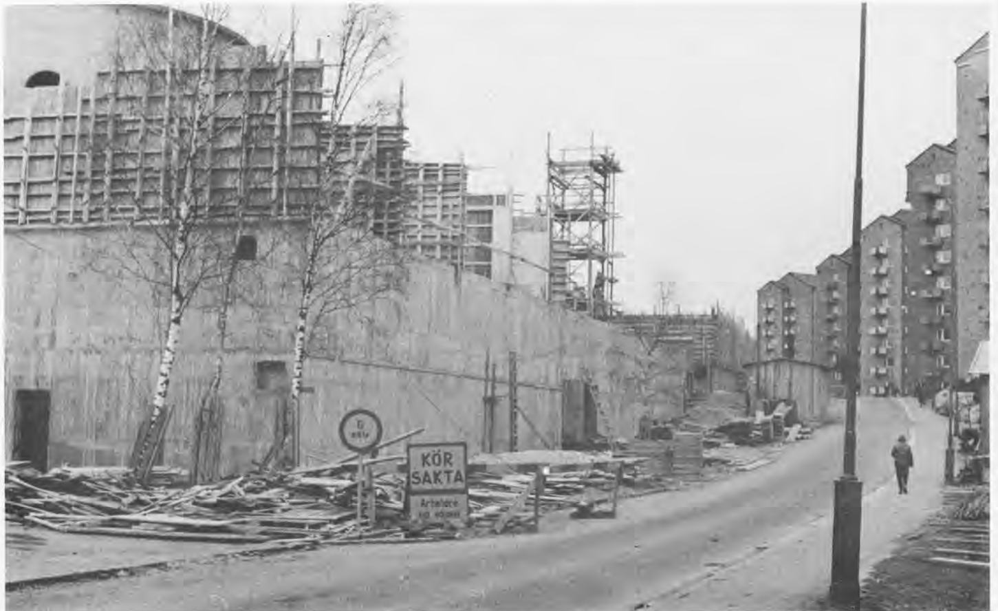
Ateljéhuset på Syster Estrids gata under byggnad. Foto Tore Ahnoff
